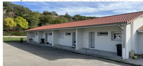
Des travaux de réhabilitation ont été effectués sur 7 pavillons, notamment pour une économie d'énergie d'environ 60% (Isolation Thermique par l'Extérieur, pose de ballons thermodynamiques ...).
