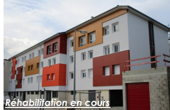
Réhabilitation en cours
